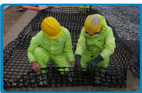
Fotografía 3. Alistamiento y ensamble de los contenedores en Geoestera.
