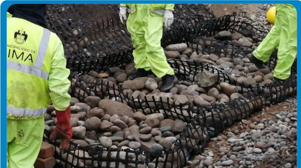
Fotografía 4. Colocación de colchón antisocavante.
