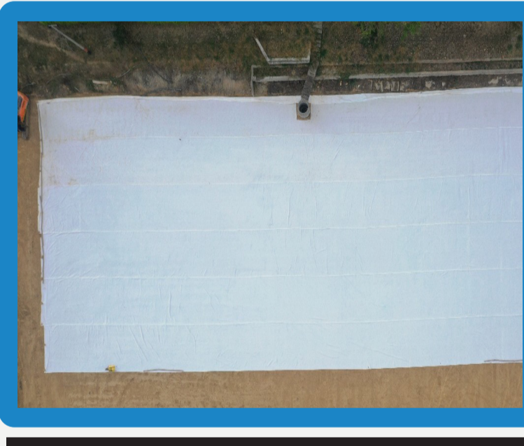
Inicio de instalación del geotextil de alto módulo por franjas cosidas
