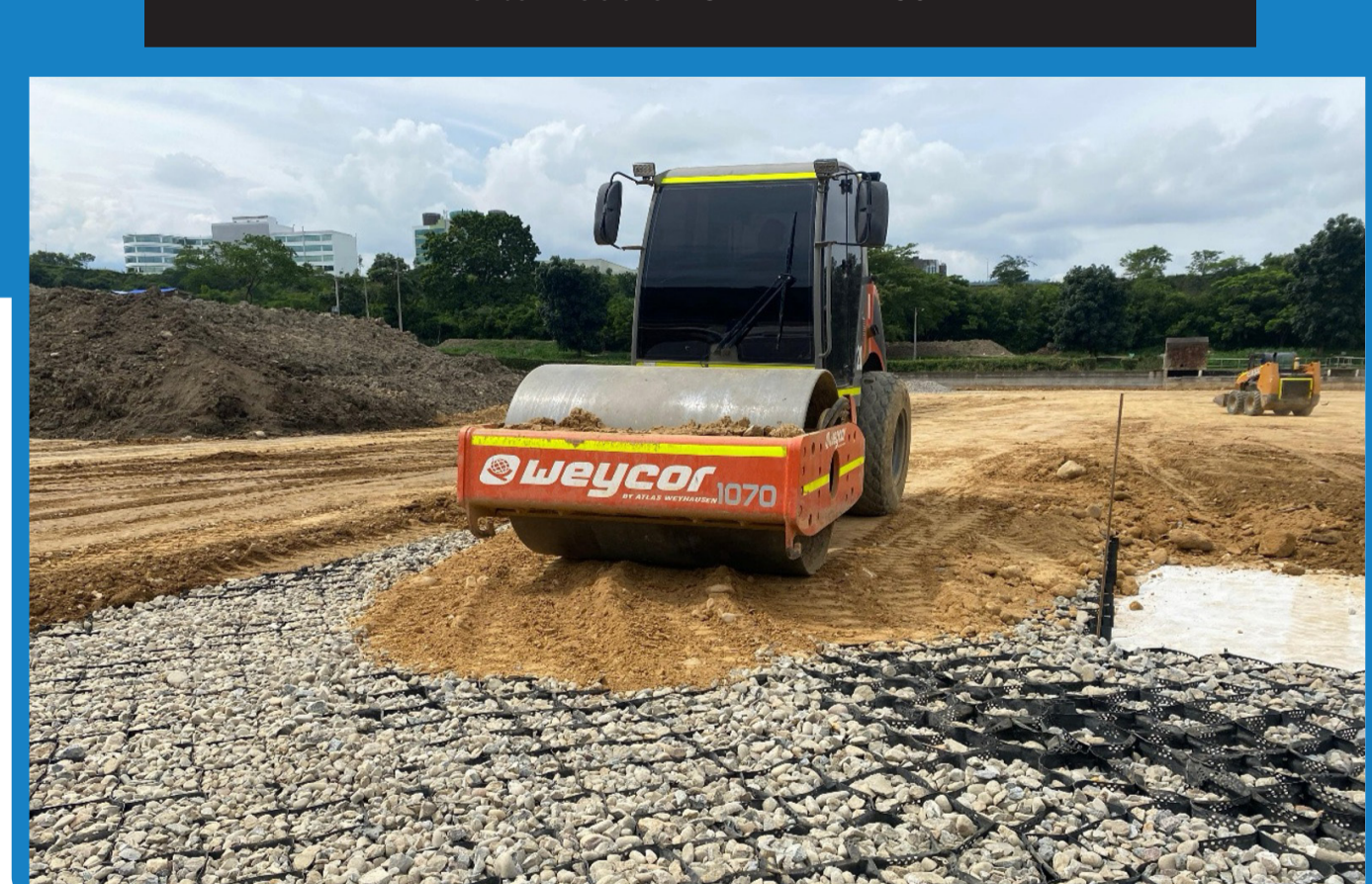
Instalación de geocelda para refuerzo en la zona de tránsito canalizado de equipos de mantenimiento
