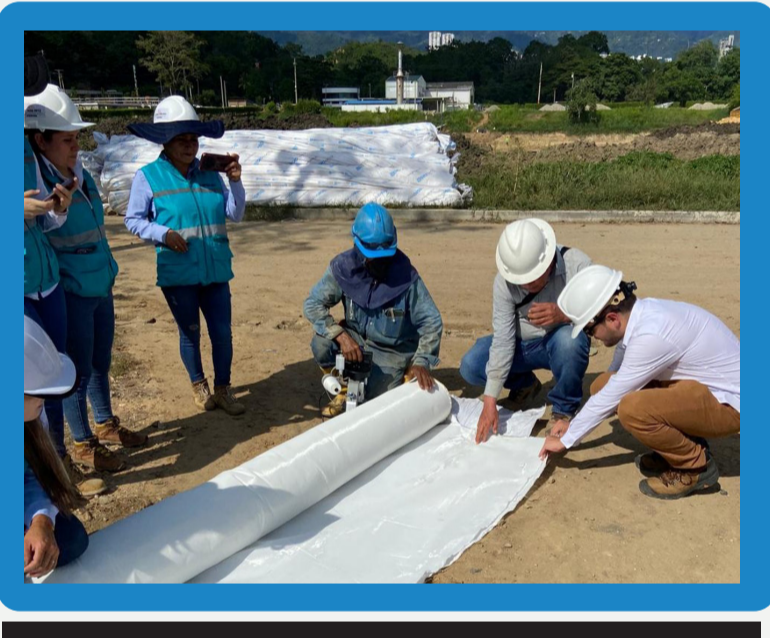
Capacitación unión de paños mediante costura del geotextil FORTEX
