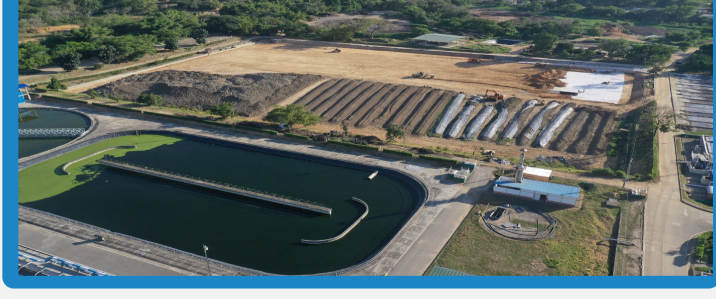
Cobertura del geotextil con material granular
