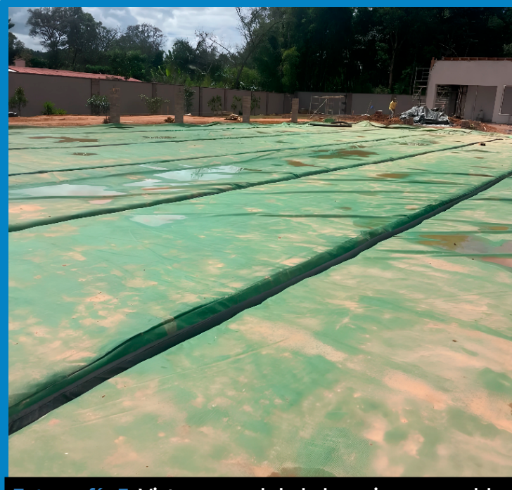
Fotografía 3. Vista general de la base impermeable y sistema de drenaje en exteriores
