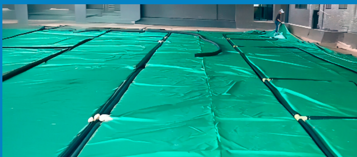
Fotografía 4. Red de subdrenaje instalada con conectores sobre geosintético textil impermeable IMPERTEX
