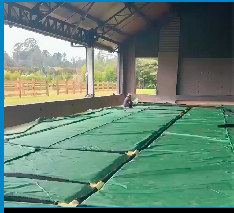
Fotografía 2. Instalación del sistema de subdrenaje Filter DrainPipe sobre IMPERTEX en área cubierta
