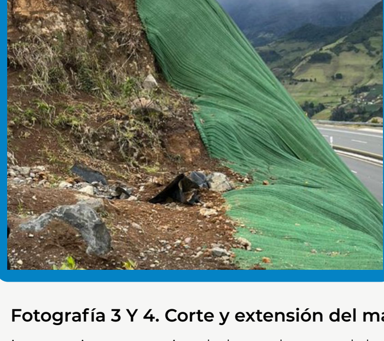
Fotografía 3 Y 4. Corte y extensión del manto: Se posiciona desde la trinchera de anclaje superior y se extiende hasta la pata del talud.
