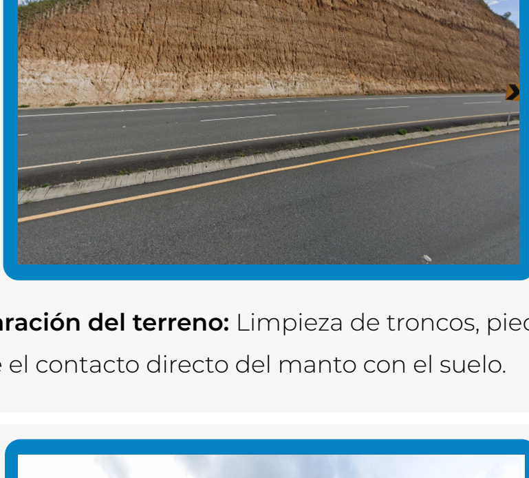
Fotografía 1. Preparación del terreno: Limpieza de troncos, piedras y cualquier elemento suelto que dificulte el contacto directo del manto con el suelo.
