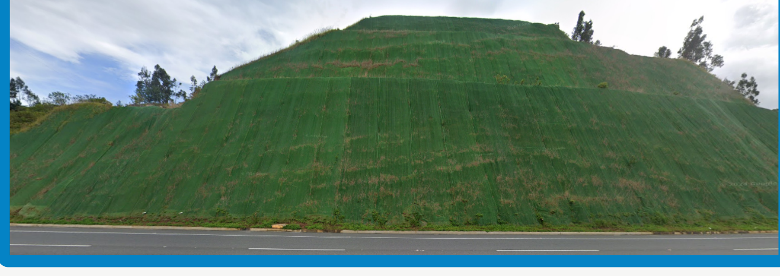
Fotografía 7. Vista frontal instalación manto para control de erosión TERRATRAC. Realización del proyecto. Año 2021
