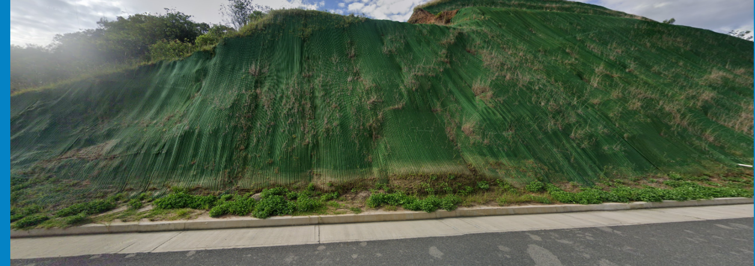
Fotografía 9. Posterior a su finalización se evidenció un rápido establecimiento de la vegetación en el talud, generando una armonía con el entorno de la zona. Realización del proyecto. Año 2021
