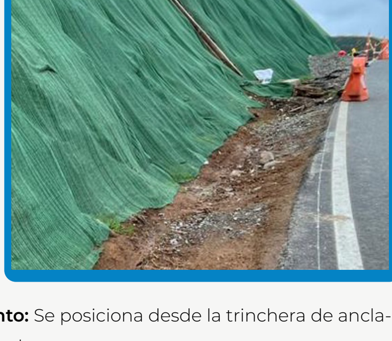
Fotografía 3 Y 4. Corte y extensión del manto: Se posiciona desde la trinchera de anclaje superior y se extiende hasta la pata del talud.
