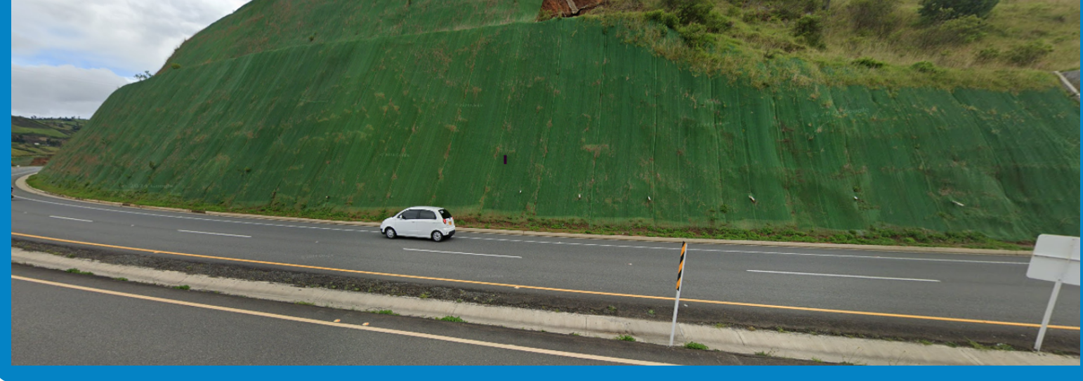
Fotografía 8. Vista panorámica instalación manto para control de erosión TERRATRAC. Realización del proyecto. Año 2021
