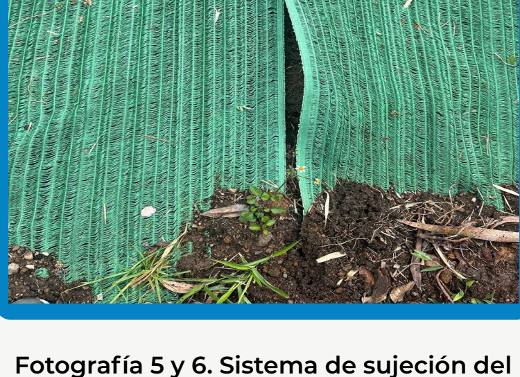
Fotografía 5 y 6. Sistema de sujeción del manto: Aseguramiento en las juntas, bordes y zonas intermedias con pines metálicos de anclaje
