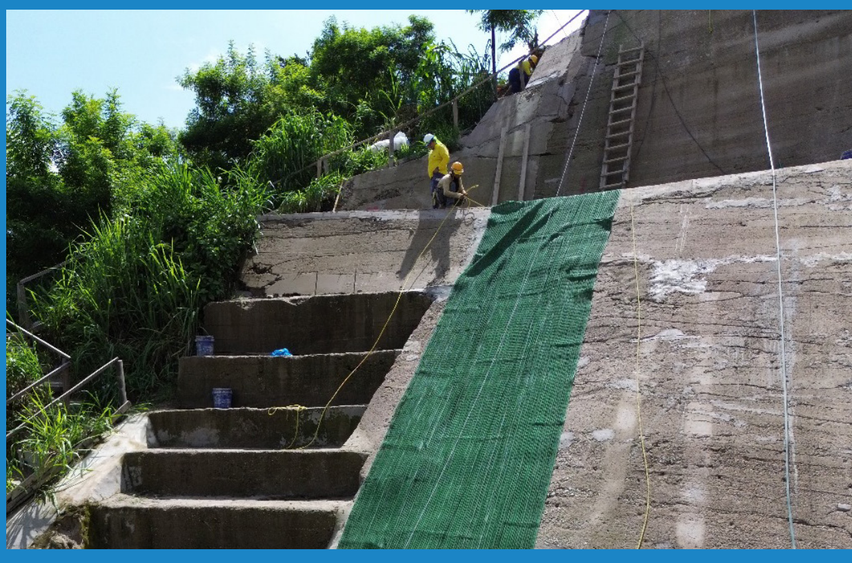
Fotografía 3. Extendido del manto sobre el talud revestido con lodocreto
