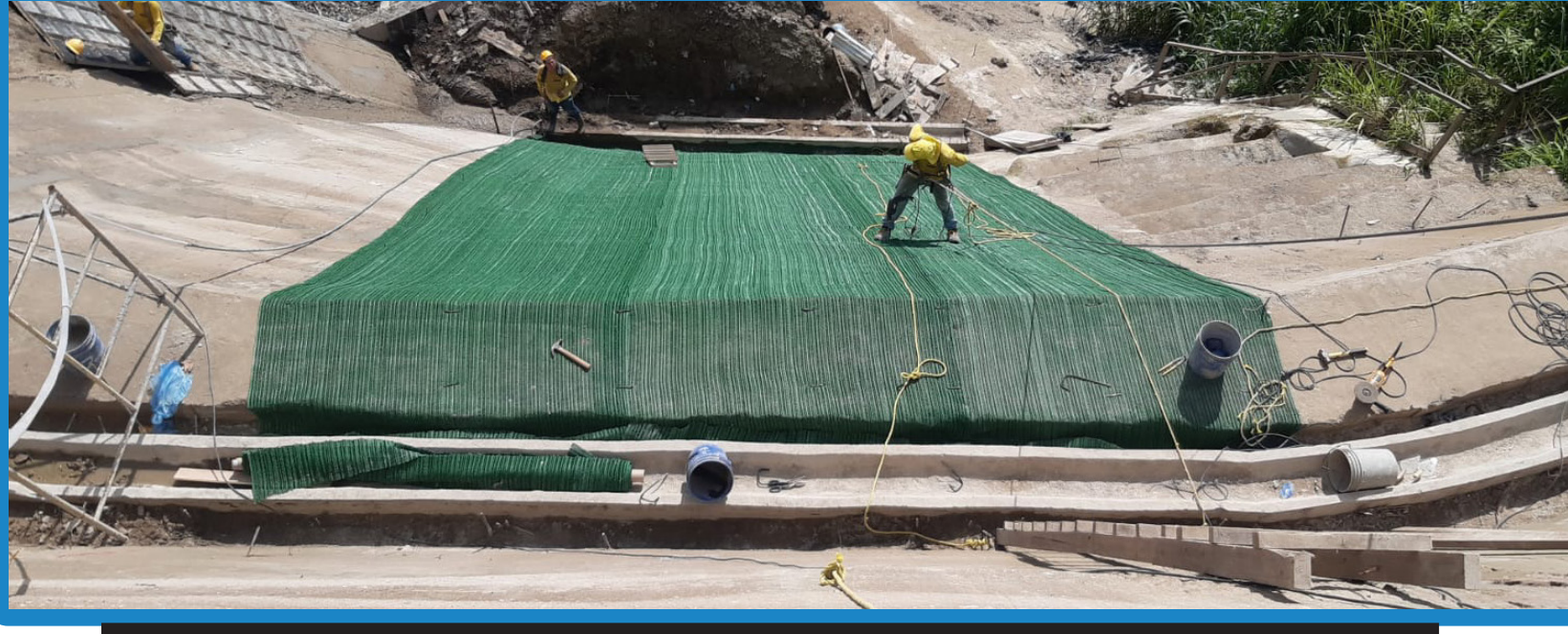
Fotografía 2. Instalación del manto TERRATRAC desde la trinchera de anclaje en la corona del talud
