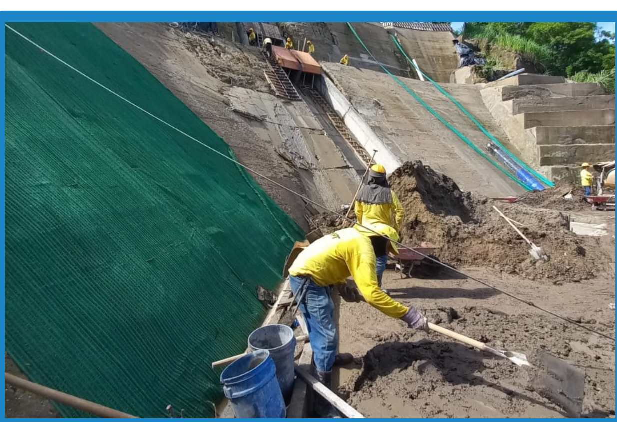
Fotografía 5. Anclaje del manto en la parte inferior del talud y revestimiento con lodocreto
