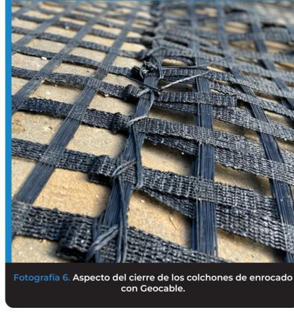
Fotografía 6. Aspecto del cierre de los colchones de enrocado con Geocable.
