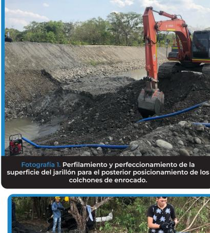
Fotografía 1. Perfilamiento y perfeccionamiento de la superficie del jarillón para el posterior posicionamiento de los colchones de enrocado.
