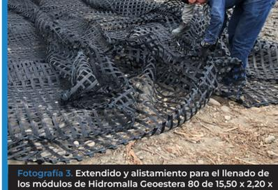
Fotografía 3. Extendido y alistamiento para el llenado de los módulos de Hidromalla Geostera 80 de 15,50 x 2,20 x 0,30 m.
