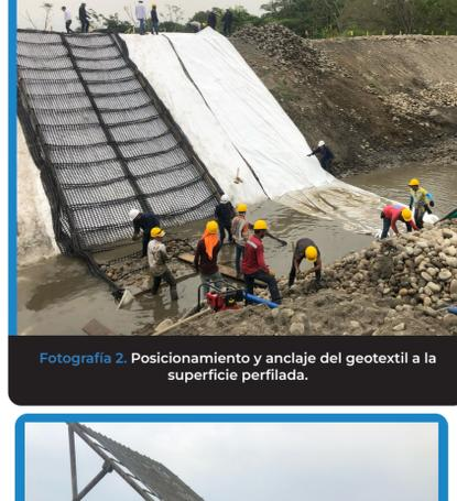
Fotografía 2. Posicionamiento y anclaje del geotextil a la superficie perfilada.
