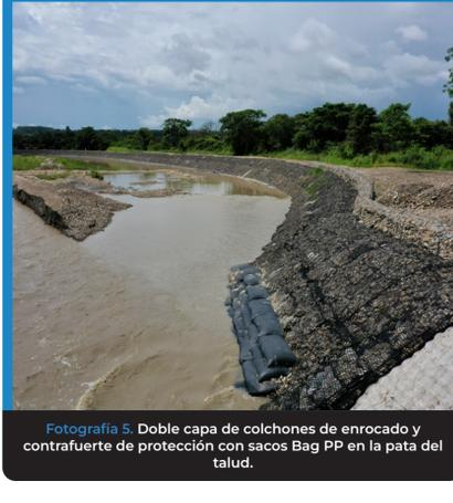
Fotografía 5. Doble capa de colchones de enrocado y contrafuerte de protección con sacos Bag PP en la pata del talud.
