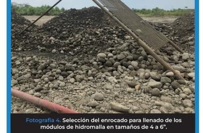
Fotografía 4. Selección del enrocado para llenado de los módulos de hidromalla en tamaños de 4 a 6”.
