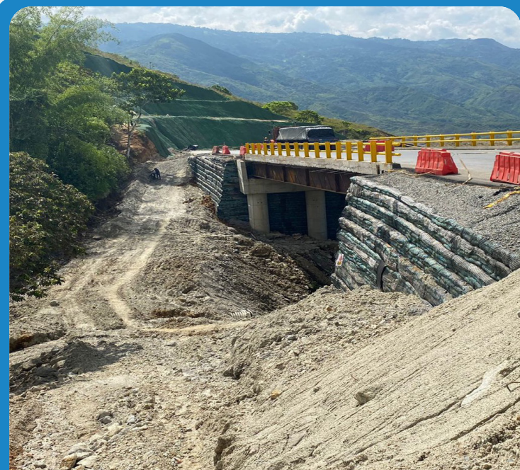
Fotografía 3. Los muros de suelo reforzado fueron diseñados con una geometría Back to Back, con capas separadas por 50 cm y una inclinación de 76° en la fachada.
