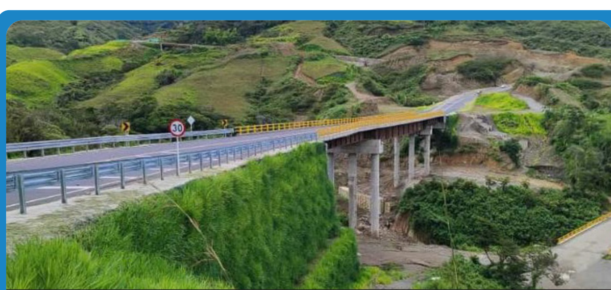
Figura 8. Finalización proceso constructivo
