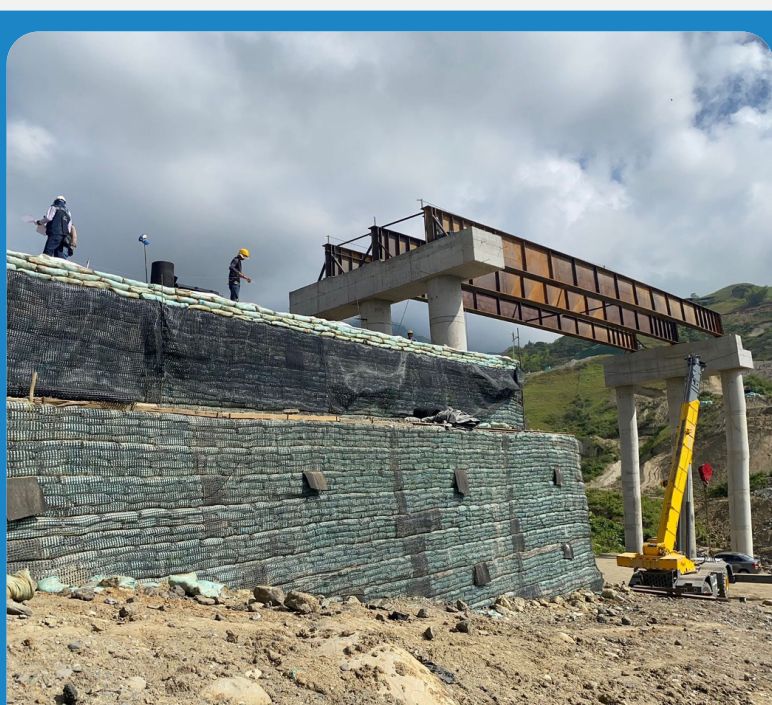
Fotografía 4. El subdrenaje de las estructuras se realizó mediante la instalación de Geodrén PERMADRAIN 450, garantizando las condiciones de humedad controlada en la masa de suelo reforzado.
