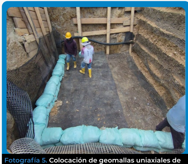
Fotografía 3. Entibado de seguridad y preparación del terreno.
