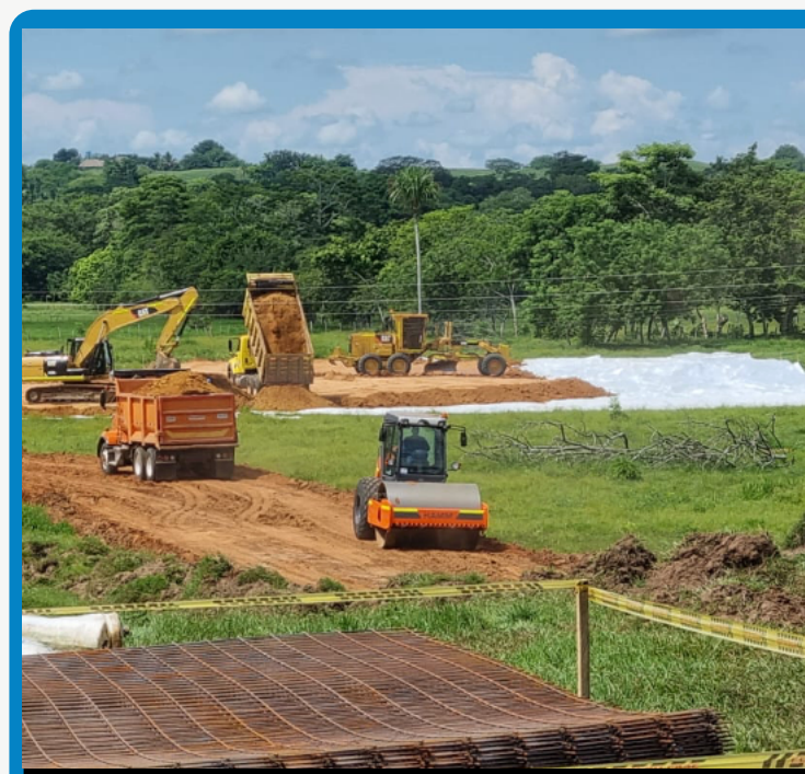
Fotografía 5. Construcción de plataforma y vía de acceso
