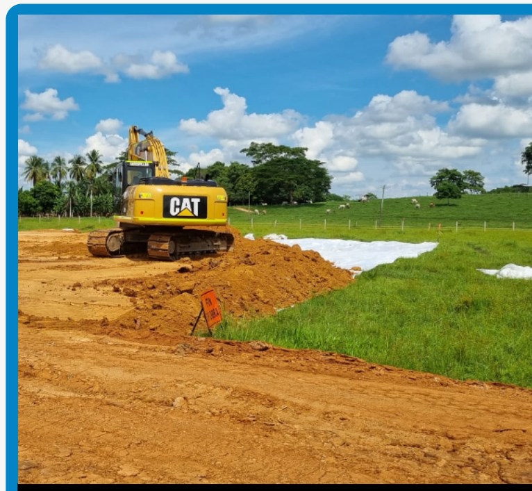
Fotografía 4. Extendido y compactación del suelo de conformación.
