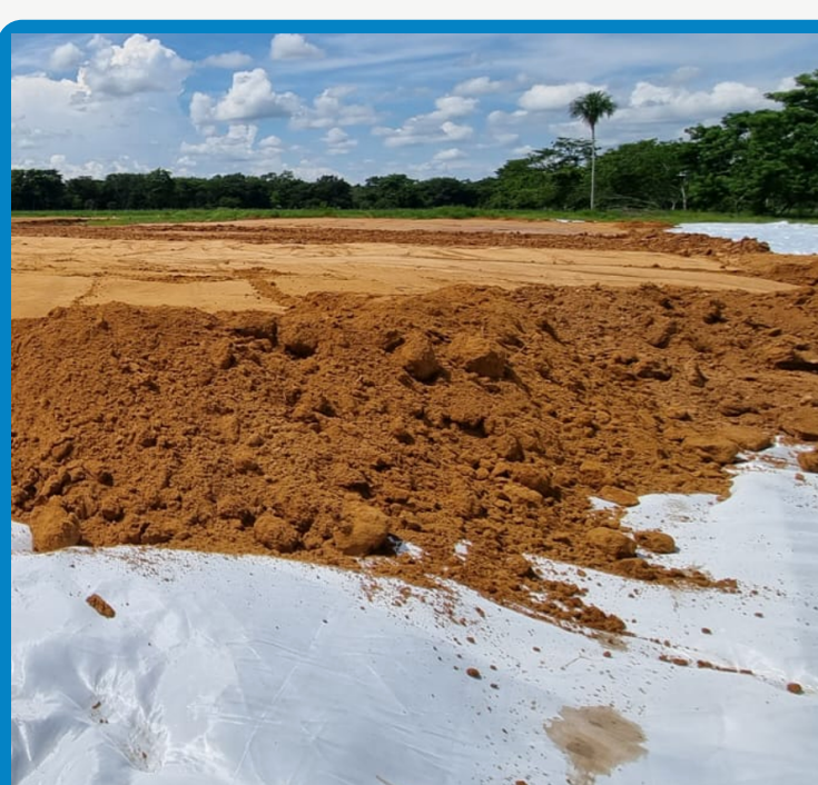
Fotografía 3. Colocación del suelo de conformación.
