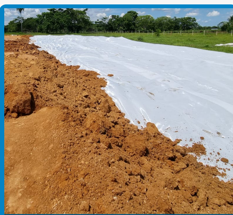
Fotografía 2. Instalación de geotextil para separación y refuerzo.
